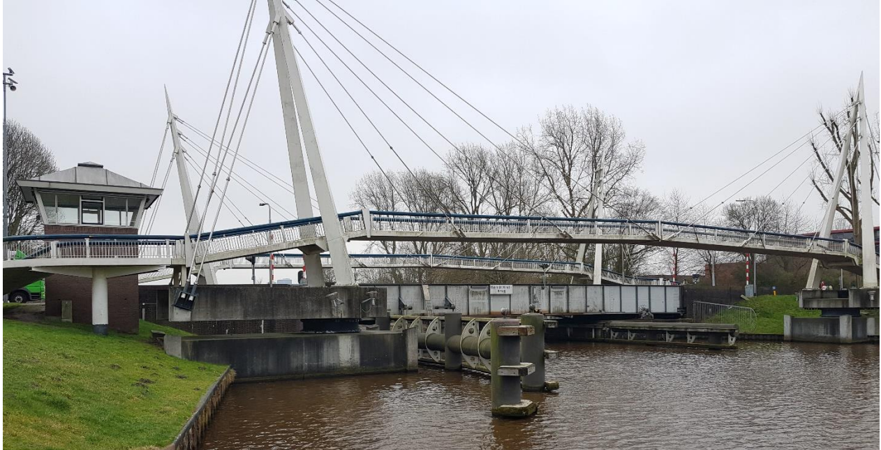
Figuur 1 Gerrit Krolbrug huidige situatie (voor aanvaring van de Gerrit Krolbrug in mei 2022)
