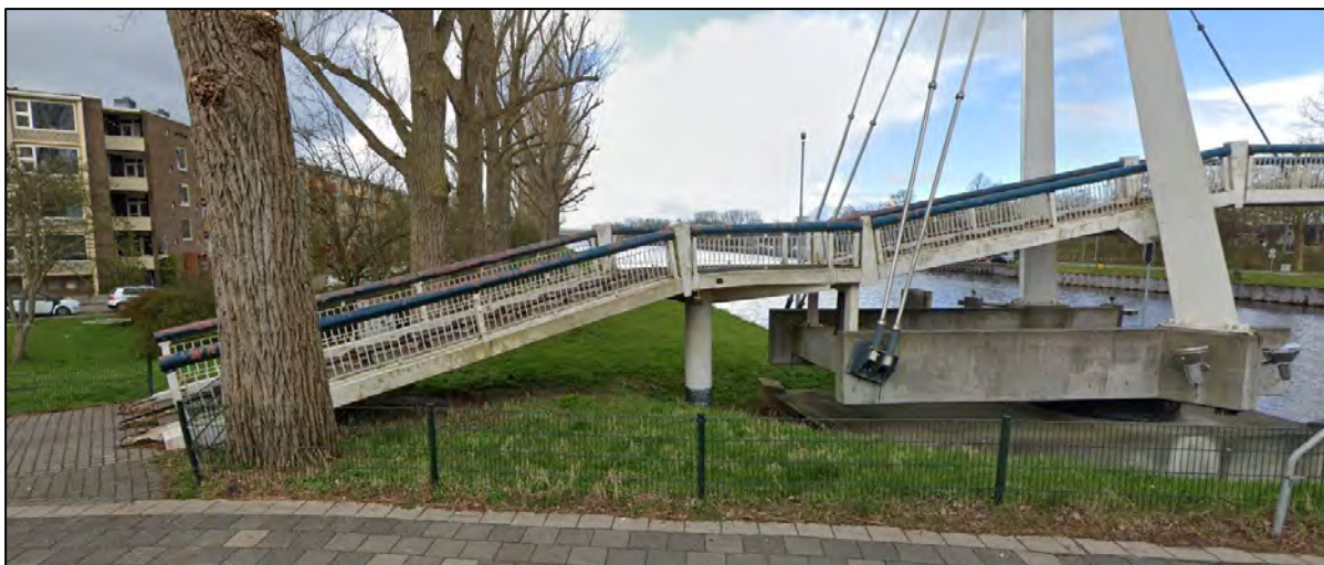
Figuur 9: Funderingen voet/fietsbrug.
